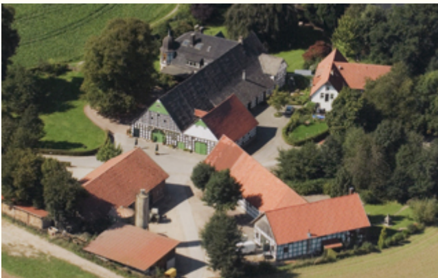
(13) Der heutige Hof Upmeier zu Belzen in einem Luftbild von 2010
